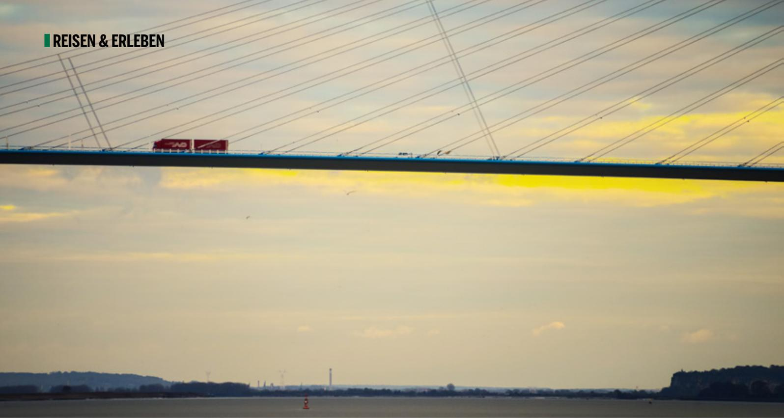
Der Pont de Normandie ist eine Schrägseilbrücke, die mit 856 Metern die größte Spannweite in Europa besitzt
